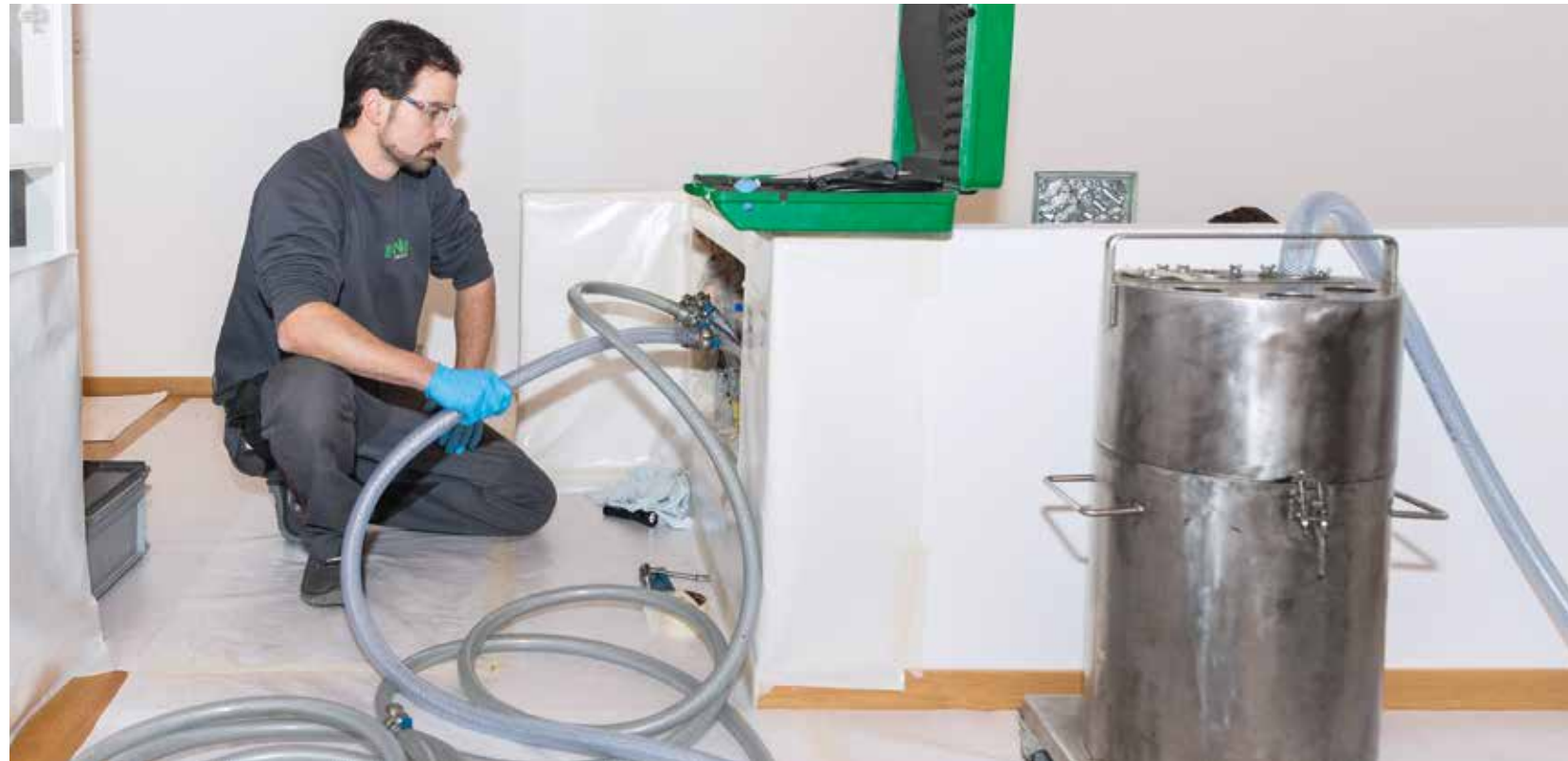
Sanierung mit dem Original: HAT-System.
