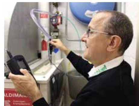
Umfassende Zustandsanalyse vor Ort.
