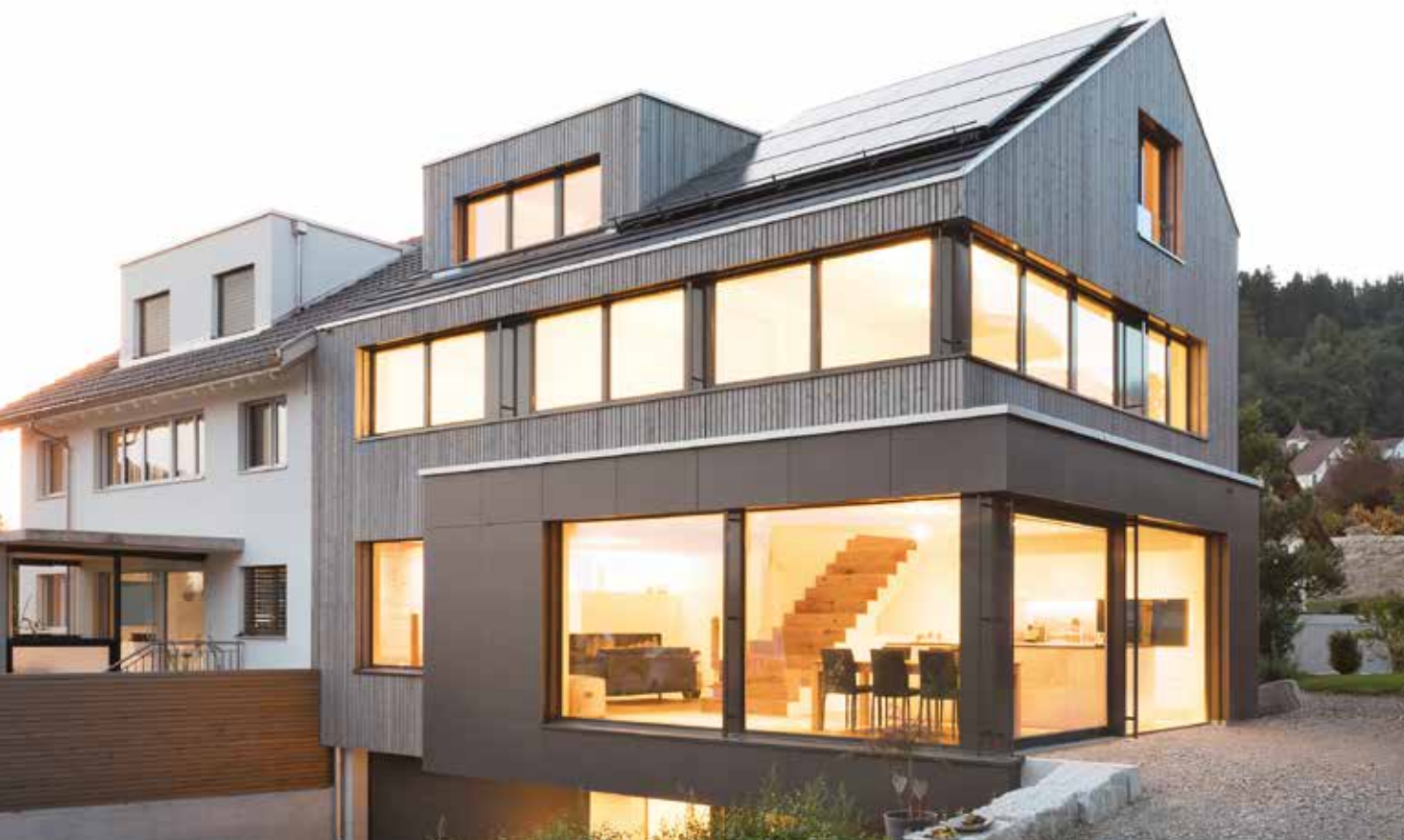
Moderne Fenster sorgen für mehr Licht, weniger Lärm und vor allem weniger Energieverlust dank Dreifachverglasung und sehr guten Dämmwerten.
