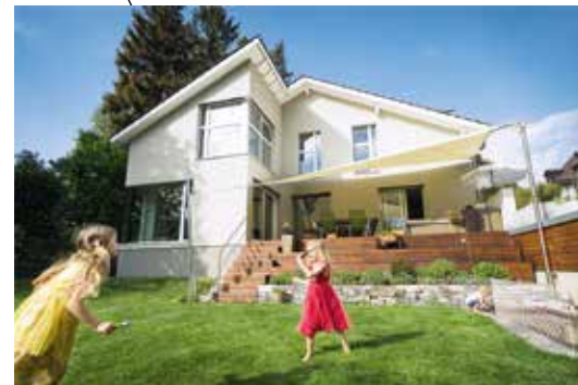
Aus dem schlecht isolierten 40er-Jahre-Haus wurde ein modernes und energieeffizientes Familienheim.
