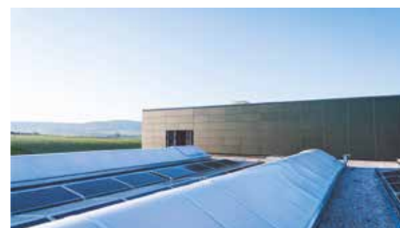
Solar-Fassaden-Anlage in Büsserach
