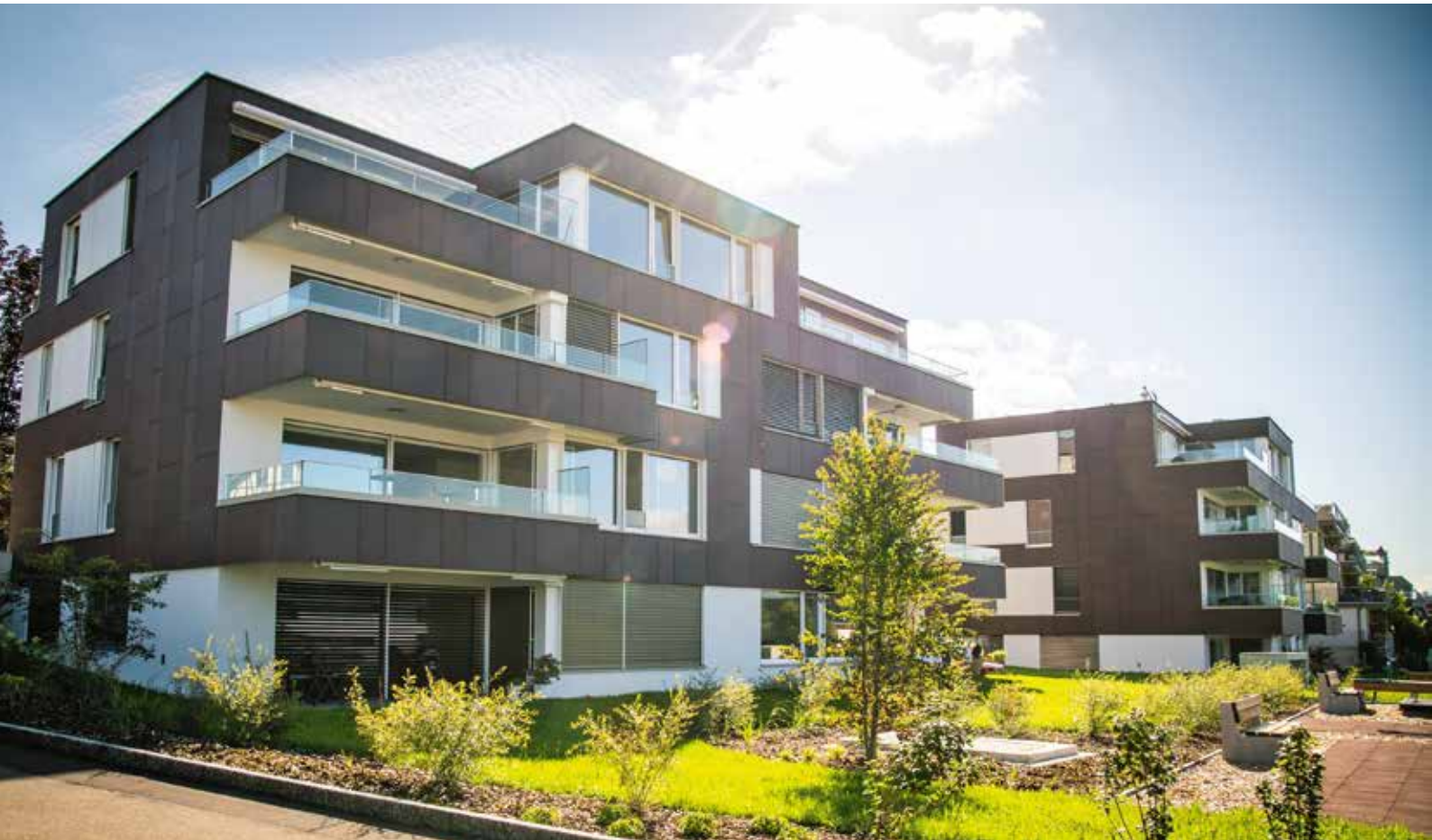
Keine normale Fassade: Mit Dünnschichtzellen eingekleidetes Haus in Männedorf ZH.
