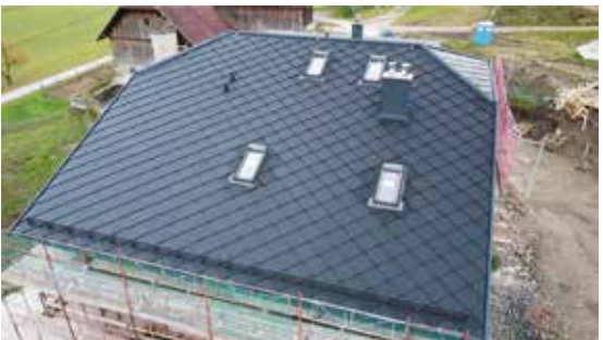
Solardächer sind heute diskret und so wetterbeständig wie jedes andere Dach auch.
