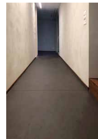
Kalkwände, kombiniert mit einem fugenlosen Zementboden.
