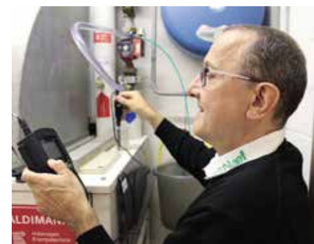
Umfassende Zustandsanalyse vor Ort.
