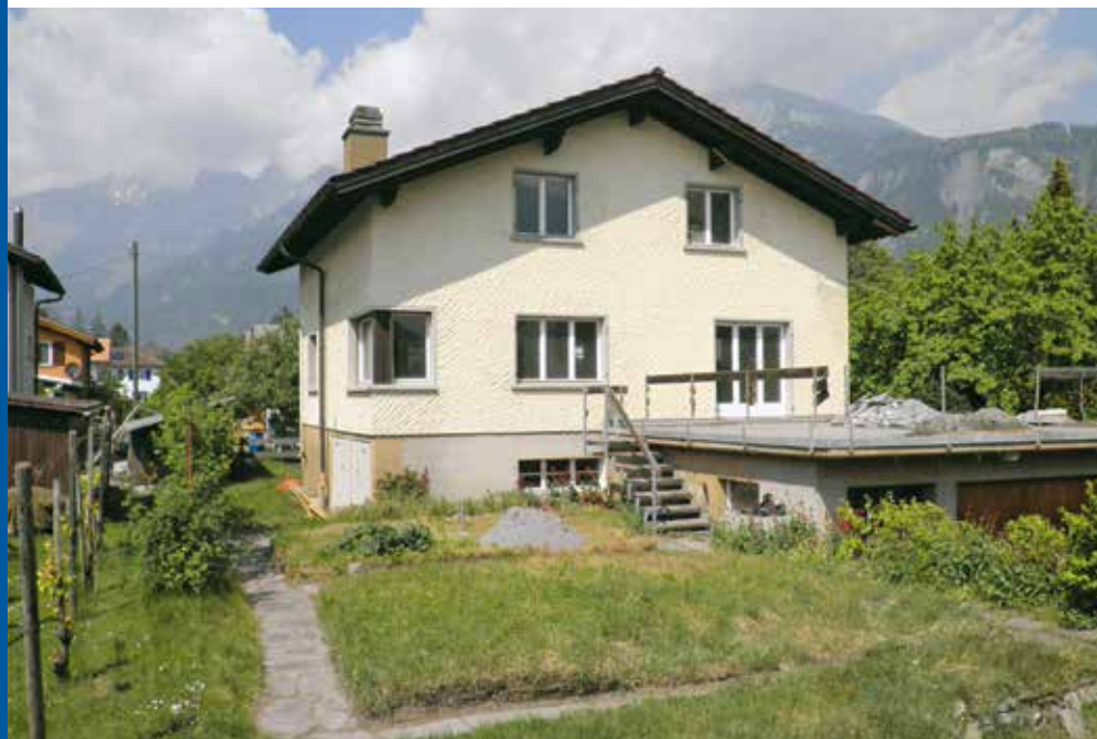
Das Einfamilienhaus aus den Sechzigerjahren...
