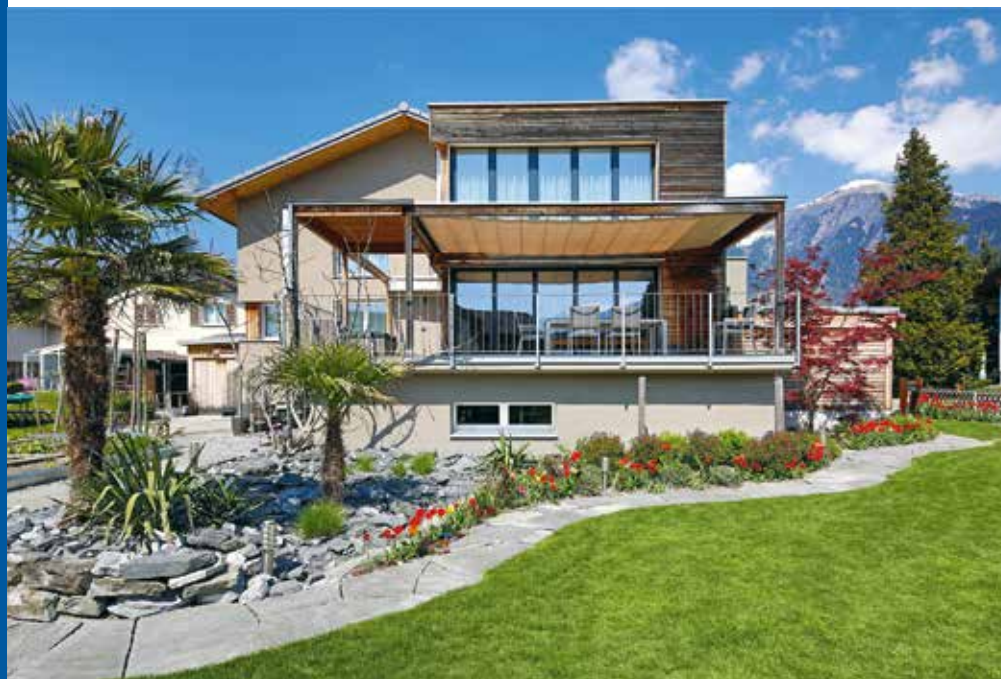
... ist nach der etappierten Sanierung
