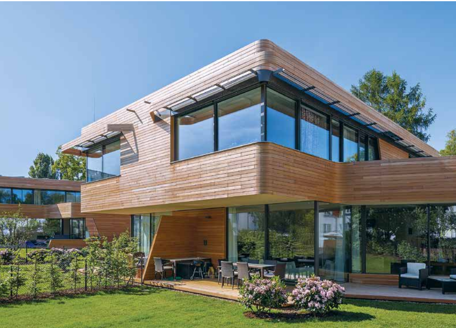
Neue Baumaterialien und Technologien erlauben auch bei Energiesparhäusern architektonische Highlights.
